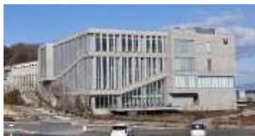
早稲田リサーチパーク・コミュニケーションセンターの外観
